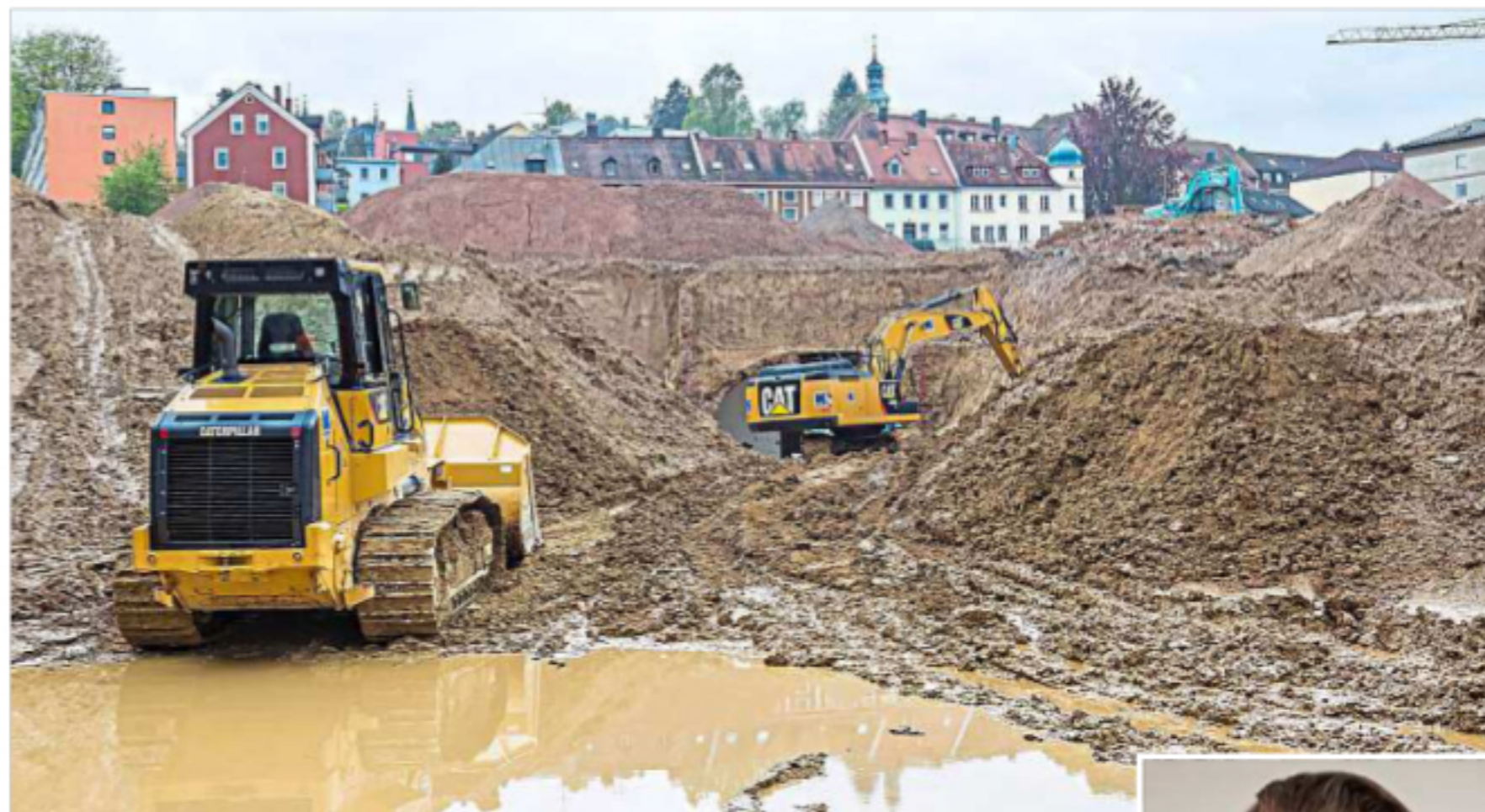
Das Feld ist so gut wie bestellt: Auf dem 21 400 qm großen Areal soll nach dem Brauerei-Abriss möglichst schnell Baurecht für die „Peschl-Quartiere“ geschaffen werden. Die Hochbaumaßnahmen könnten dann von einer neuen Gesellschaft, an der der Investor beteiligt ist, realisiert werden. – Fotos: Jäger/Gerch-Group
