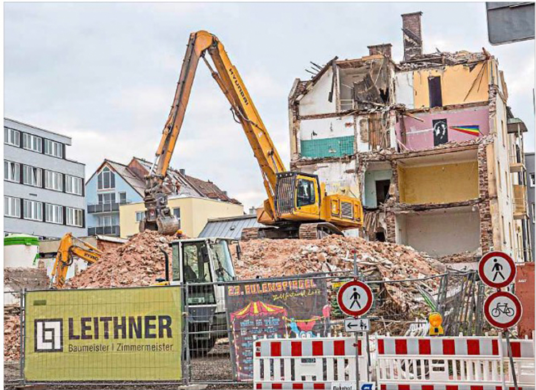
Im Zeitplan und ohne Zwischenfälle sind die Abbrucharbeiten bisher verlaufen.
