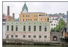
In der Turnhalle am Römerplatz entstehen rund 750 qm Wohnraum.
