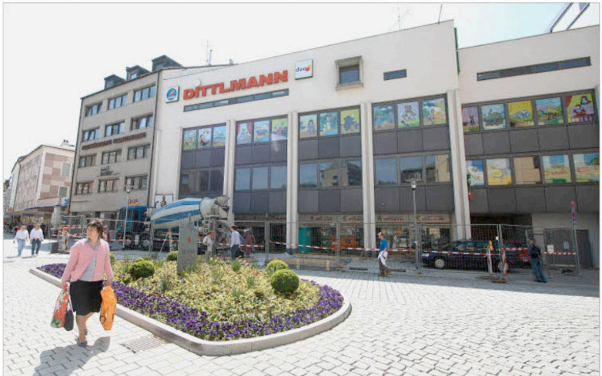
Gestern fuhr der Betonmischer vor, heute folgt der Hochkran: In den kommenden vier Monaten wird das Umfeld des Dittlmann-Hauses zur Baustelle. Danach tauchen in dem zentralen Geschäftshaus u.a. zwei neue Läden und ein aufgestocktes viertes Geschoss auf. – Foto: Jäger
