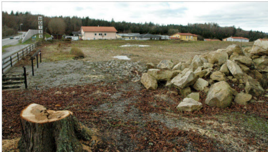
Abgeschlagene Bäume und Steinhaufen zeugen noch vom einstigen Biergarten und Gebäude des Passauer Traditionslokals Albrecht. Auf dem knapp 8000 Quadratmeter großen Areal entsteht ab Fröhsummer 2015 jetzt der Wohnpark „Albrecht-Karree“ mit acht Mehrfamilienhäusern und 90 Wohnungen. – Foto: Karl
