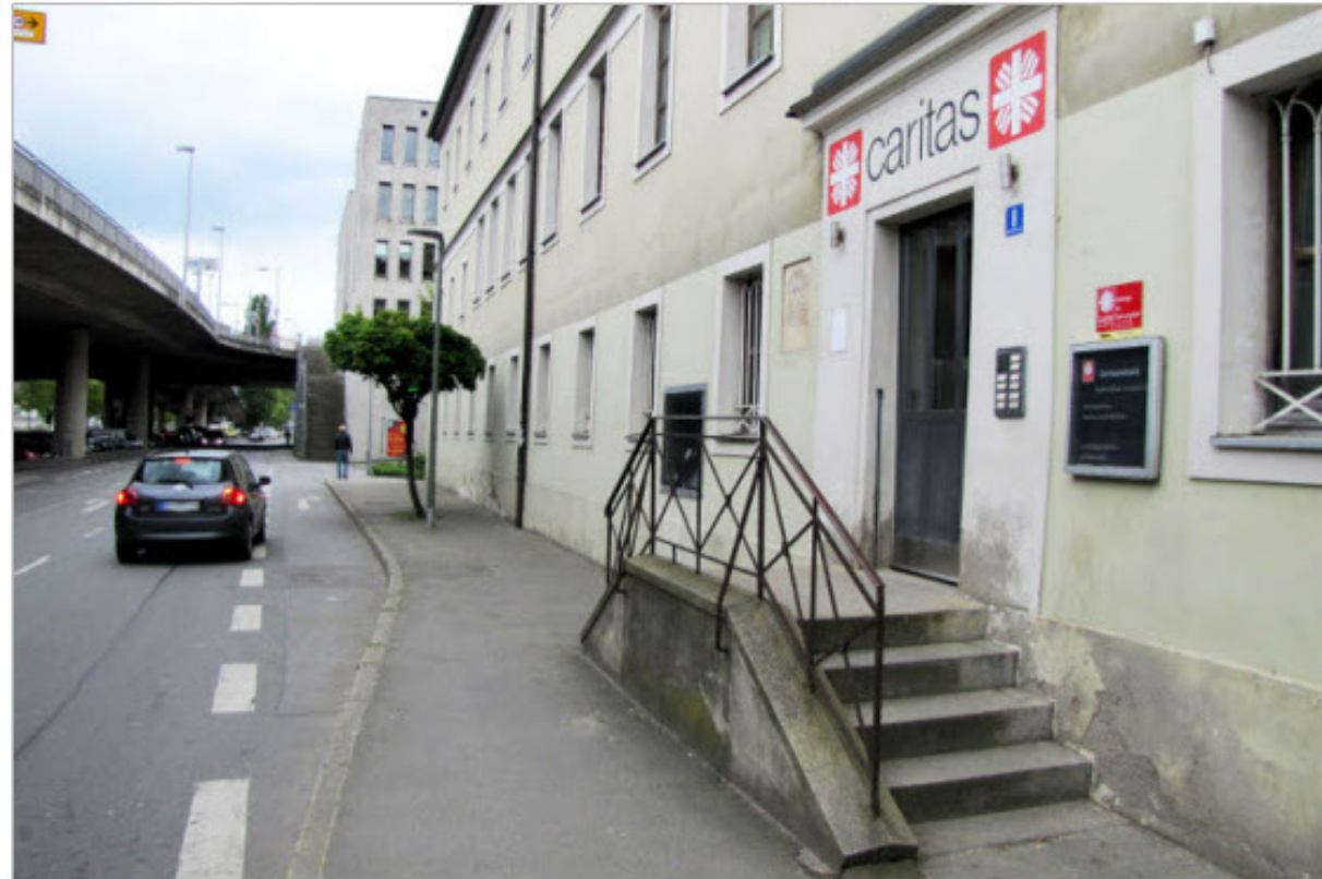
Das altherwürdige von der Caritas angemietete „Konradinum“ an der Donaulände, wo Beratungsstellen, Substitution, Herberge und Kleiderkammer untergebracht sind, steht eventuell vor dem Abriss. – Fotos: Karl
