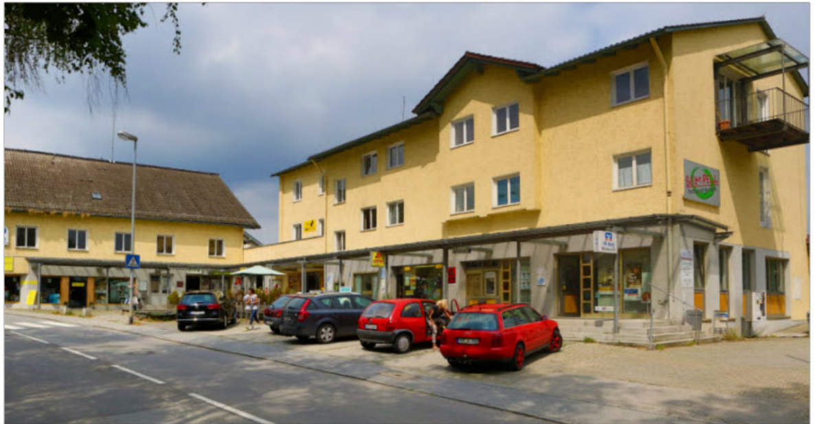
Der Pell-Komplex, der jahrelang das Stadtteil-Leben von Kunden, Gästen und Patienten in Neustift prägte, soll nach neuesten Investoren-Plänen im kommenden Frühjahr komplett abgerissen werden. Im Jahr darauf soll dort das moderne „Stadtteilzentrum Passau-Neustift“ stehen. – Foto: Jäger
