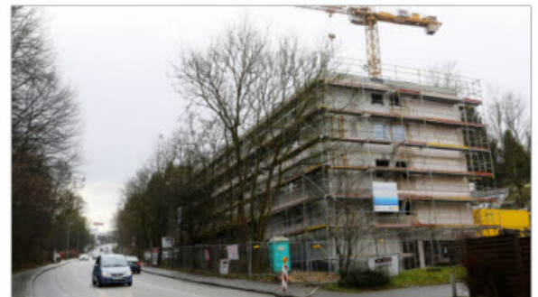
Ein Hotel mit 84 Zimmern wird an der Danziger Straße gebaut. Die Hotelkette „B & B“ investiert nach eigenen Angaben vier Mio. Euro.
