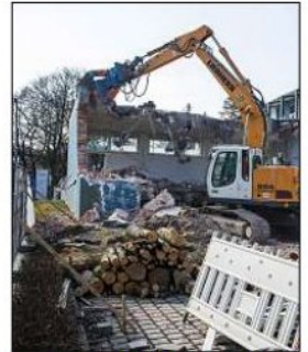
Erst Abriss, dann Anbau: Die GKS in Kohlbruck baut aus.
