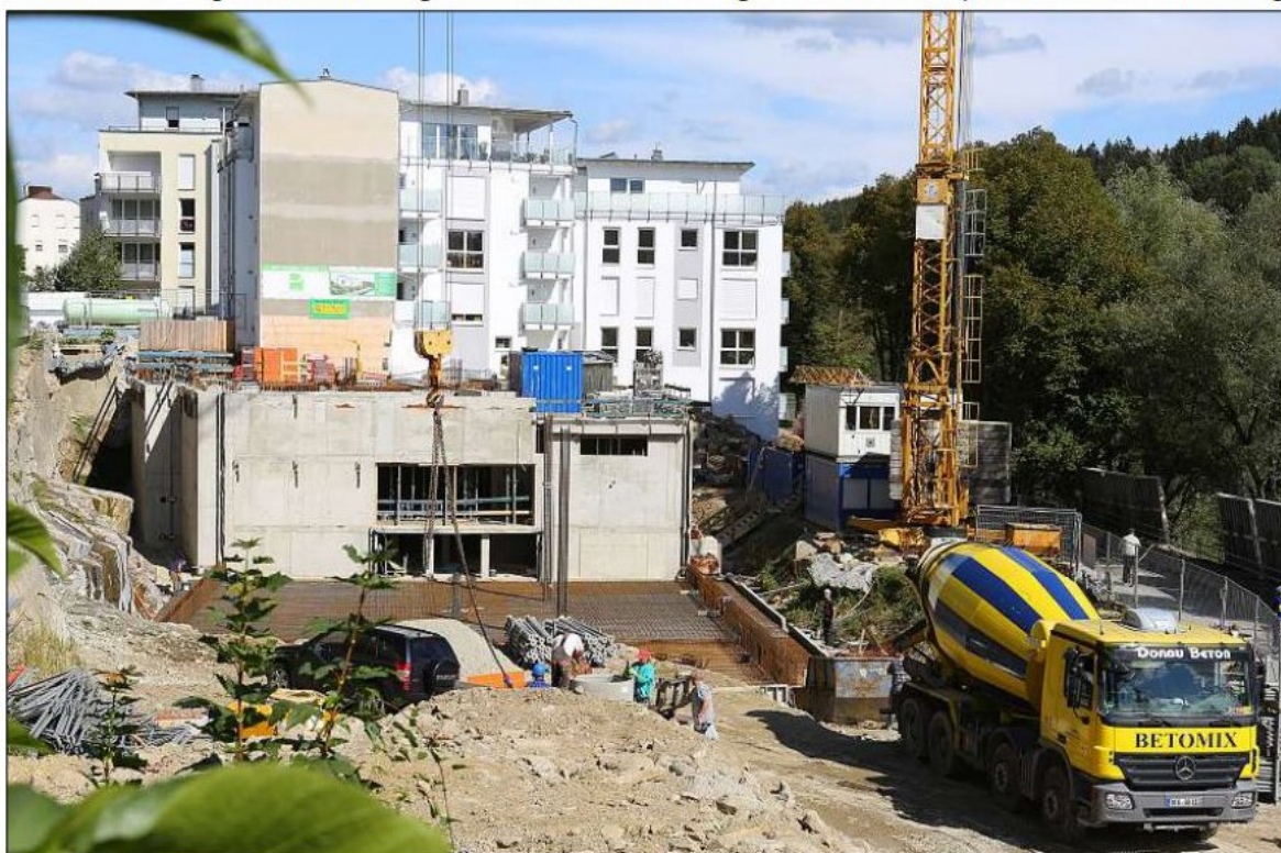
An der Passauer Innstraße entstehen derzeit neue Wohnungen mit direktem Innblick. Bei neu geschaffenem Wohnraum in der Dreiflüssestadt liegen die Preise 2015 der PNP-Umfrage zufolge um bis zu zehn Prozent über jenen des Vorjahres. – Foto: Thomas Jäger
