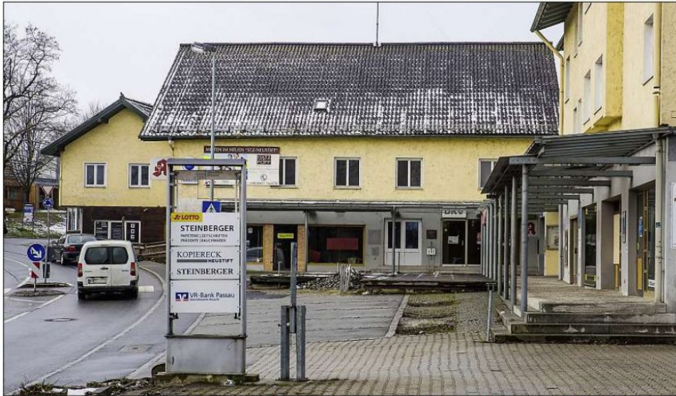
Letzter Blick auf den kompletten, aber zusehends verfallenden Komplex in Neustifts Ortsteil-Mitte. Am Montag startet der auf gut acht Wochen terminierte Abriss des Gebäudes. Im März/April 2017 soll Eröffnung für das 20-Millionen-Projekt „Neustift-Center“ sein.
